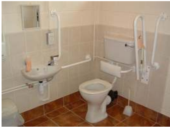
تصویر ۱۳: نحوه مناسب سازی توالت و حمام برای استفاده معلولین منبع: ۶
