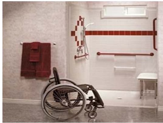
تصویر ۱۳: نحوه مناسب سازی توالت و حمام برای استفاده معلولین منبع: ۶
