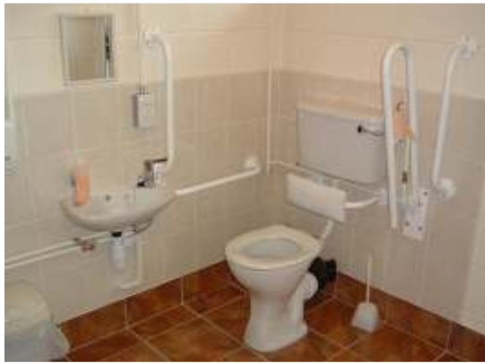
تصویر ۱۳: نحوه مناسب سازی توالت و حمام برای استفاده معلولین
